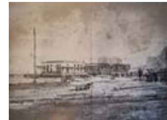
Foto 10 - Stabilimento balneare in costruzione
