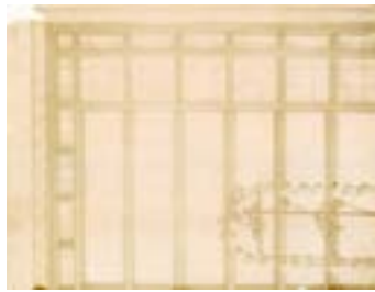
E. Basile, Sala del ristorante del Grand Café Faraglia in piazza Venezia a Roma, 1906, realizzazione delle officine Ducrot, il soffitto, fotografia d'epoca (Archivio Ducrot, Collezioni Scientifiche del Dipartimento di Architettura, UniPa)
