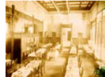
E. Basile, Sala del ristorante del Grand Café Faraglia in piazza Venezia a Roma, 1906, realizzazione delle officine Ducrot, veduta d'insieme, fotografia d'epoca (Archivio Ducrot, Collezioni Scientifiche del Dipartimento di Architettura, UniPa)
