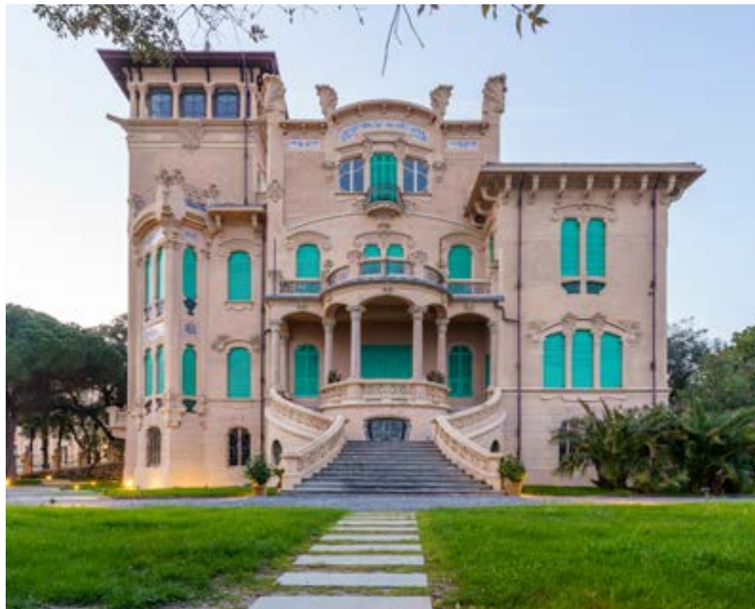
(le te fotografie) Villa Zanelli a Savona dopo il restauro conservativo. Foto del fronte lato via Nizza e lato mare. © Foto di Phil Lewis
